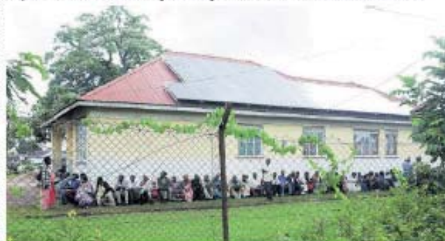
Die aus Spenden finanzierte Solaranlage sorgt für gesicherte Stromversorgung.
